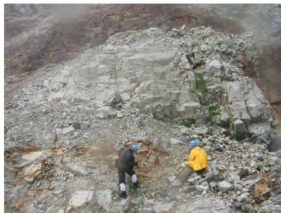
図 5 杓子岳の岩壁。人物付近は割れ目が多く、その上に割れ目の少ない部分がある。このような岩壁が落石の供給源となる（2006 年 9 月撮影）
